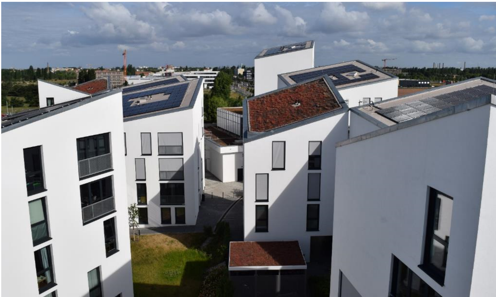
Mit Gebäudegrün vielfältige Möglichkeiten | Dr. Gunter Mann | Bundesverband Gebäudegrün e.V. (BuGG) | 26.07.2022 | www.gebaeudegruen.info
